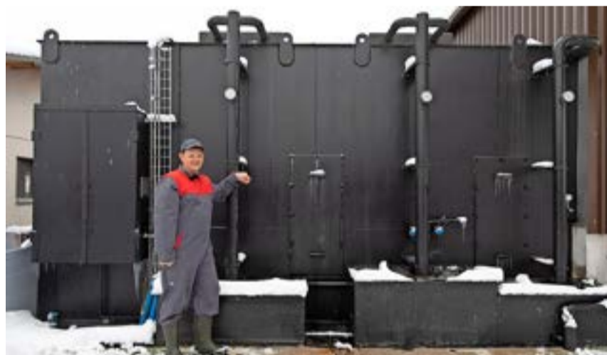
Der Biomwäscher reinigt die Stallluft in einem dreistufigen Verfahren von Staub, Ammoniak und Gerüchen.
