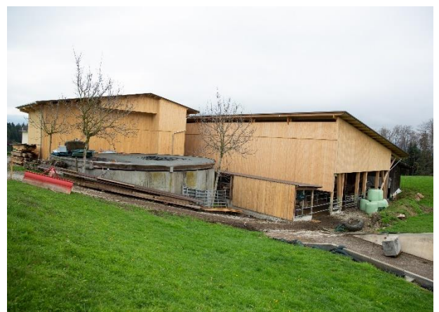
Musterstall Merlischachen: Mit Holz vom eigenen Wald gut in die Landschaft integriert. Bild: M. Wittwer
