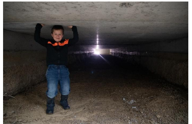
Bild: Unterflur-Schacht zum Ansaugen von Luft für den Schweinestall. Dieser kühlt im Sommer und wärmt im Winter die Stallluft. Mustebetrieb Sigrist (S1), Ufhusen LU; Bild: M. Wittwer
