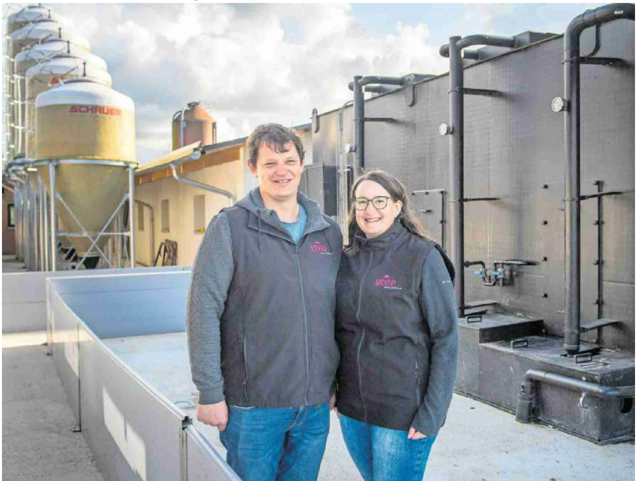
Esther und Kaspar Sigrist haben auf ihrem Hof einen Musterstall für Schweine gebaut. Das Herzstück ist der schwarze Kasten, die Luftwäschanlage. Bild: Boris Bürgisser (Ufnusen, 11. 3. 2024)
