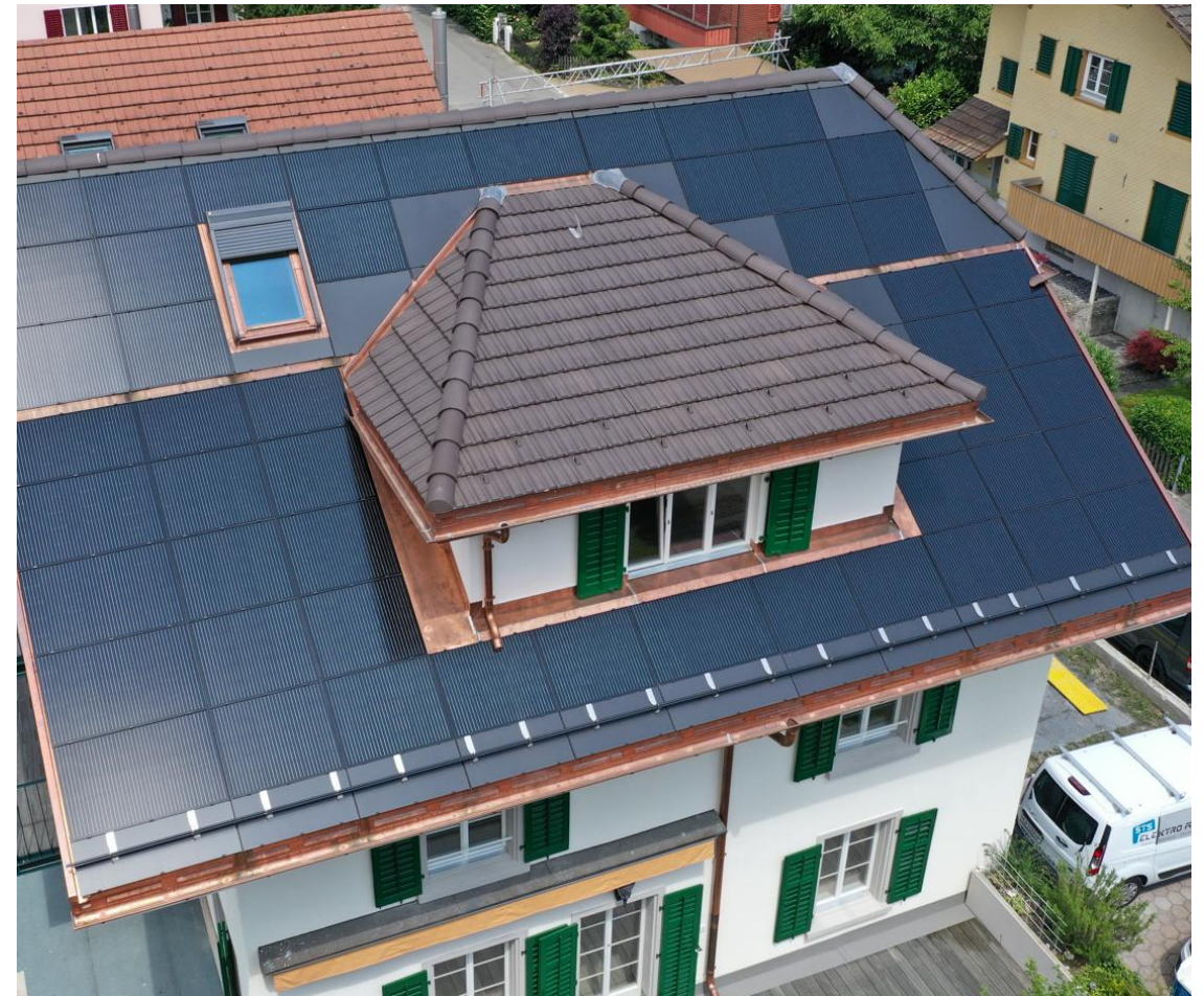
Indach-Lösung auf Einfamilienhaus
