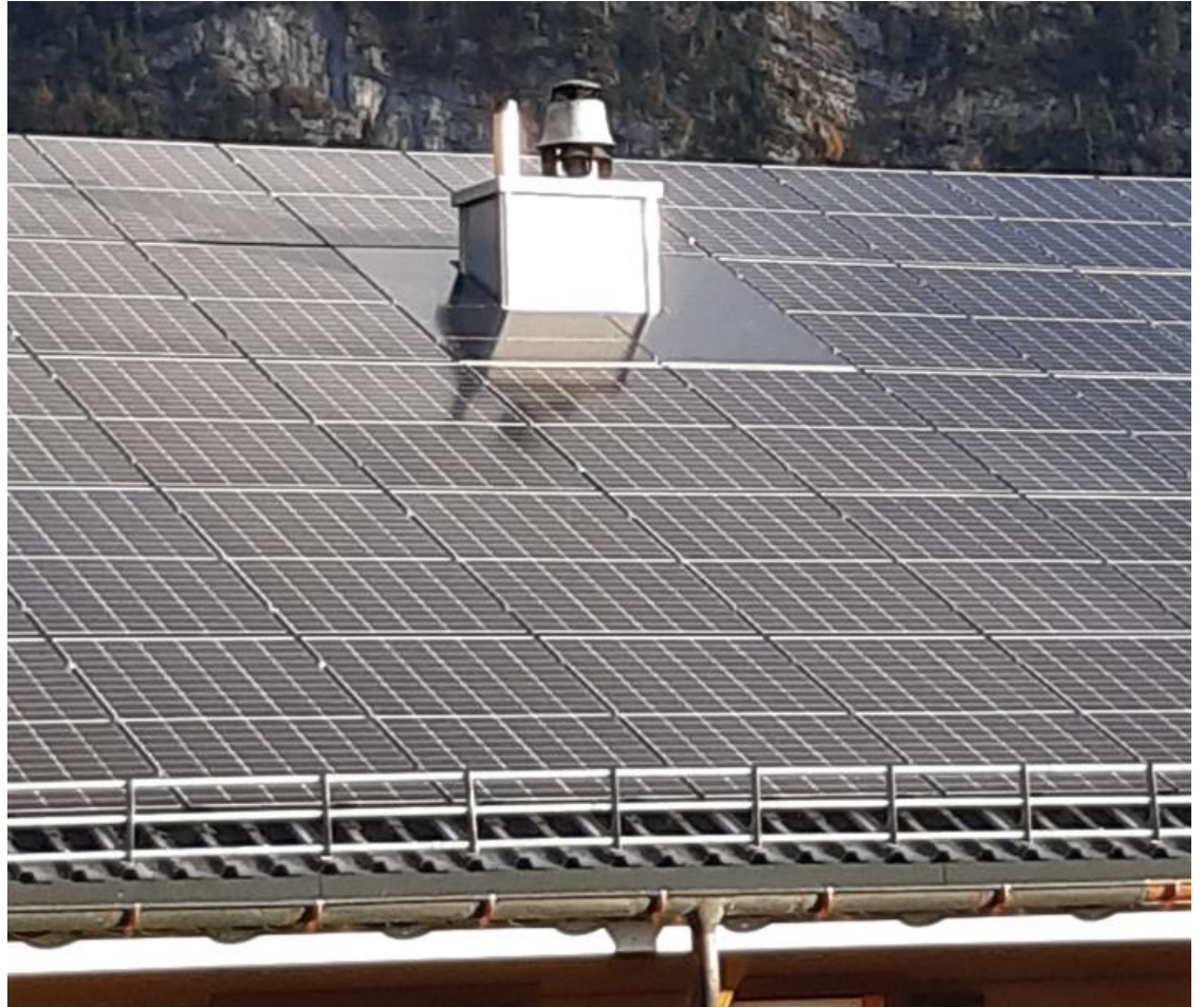
PV-Anlage auf Mehrfamilienhaus
